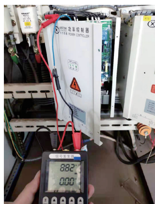
图3 检测控制信号电流值
