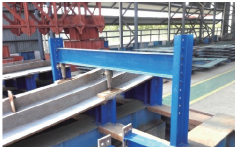
图2 扭曲板单元胎架上组焊
