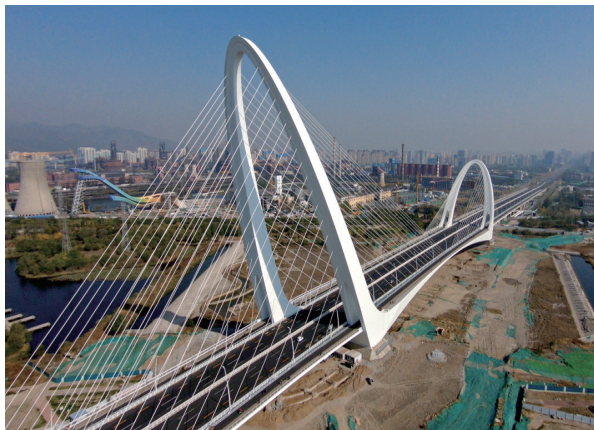
图1 永定河特大桥外形
