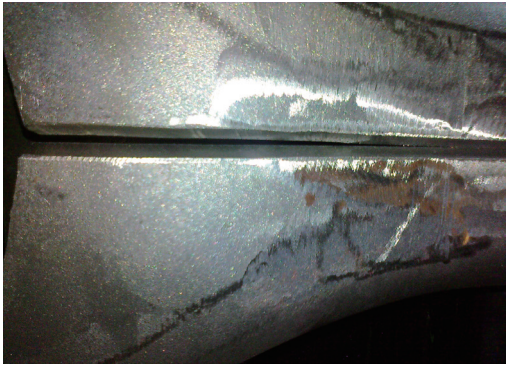
图5 坡口根部缝隙
