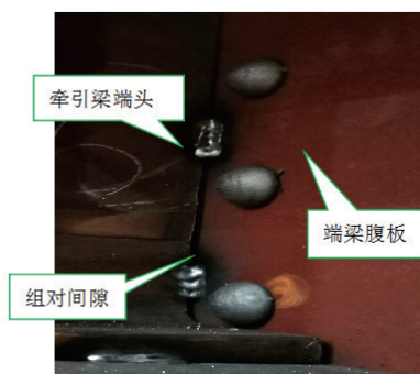
图4 牵引梁与端梁组对后内部实物
