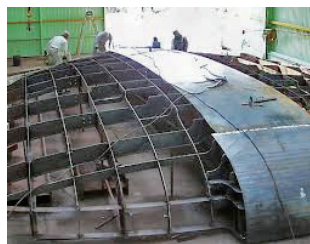
图1 船舶制造中的焊接现场
