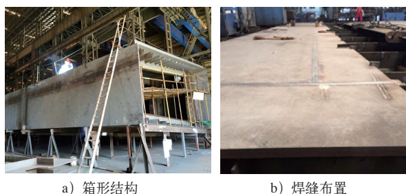
图1 龙门吊厚板焊接施工现场
