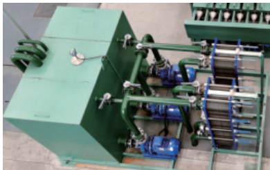
图1 铝棒感应加热炉循环水冷却系统部分装置
