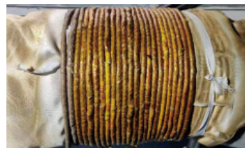
图3 中频感应加热热处理排线实物
