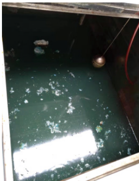
图10 冷却水蓝色结晶
