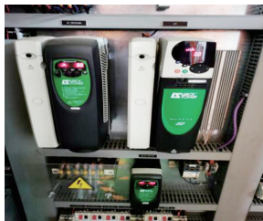
图4 升降电动机控制变频器
