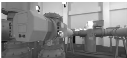
图4 GIS设备三维测绘加参数化模型
