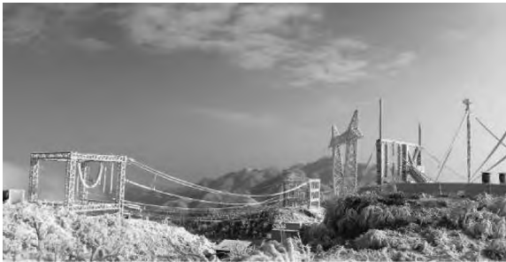
图1 雪峰山自然覆冰试验站 Fig. 1 Xuefeng mountain natural icing test station
