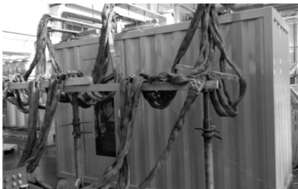
图1 电气制动开关的温升研究试验
