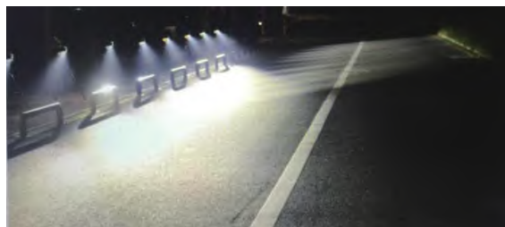
图10 低位路灯正向、逆向照明子系统同时工作
