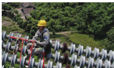
图4 安装绝缘子吊卡
