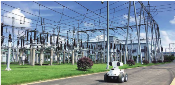
图11 室外巡检机器人
