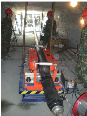
图4 液压升降平台结构图
