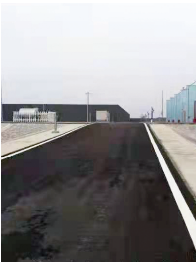
图8 特高压电站5°斜坡路面
