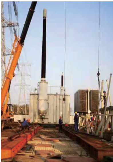
图7 电抗器整体通过钢轨往基础推移
