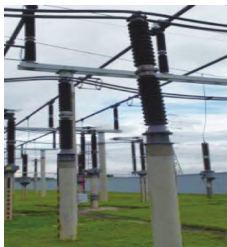
图1 歪斜的瓷支柱绝缘子
