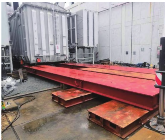
图1 变压器临时安装平台
