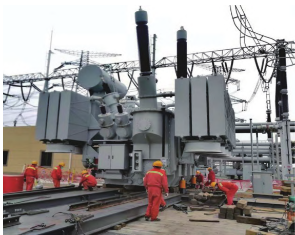
图2 重型轨道铺装
