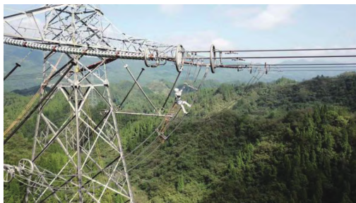
图1 等电位人员攀爬跳线示意图
