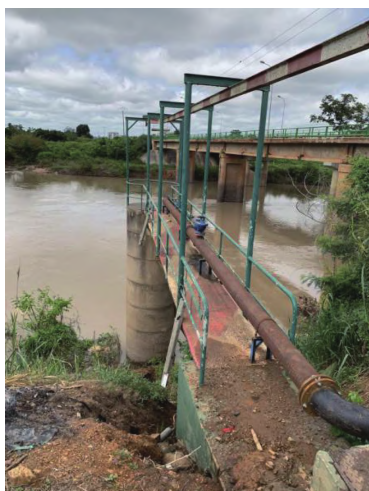
图1 圆筒沉井式取水泵站
