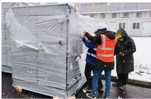
恶劣天气坚持作业
