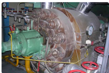
图3 内装水平中开式泵芯的国产给水泵
