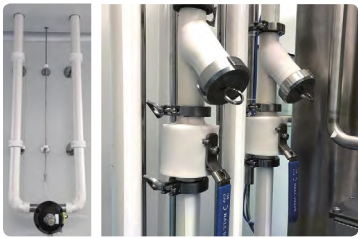
图 8 洁净型 PVDF 发泡管道保温方案
