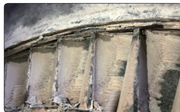
图4 1#催化烟机运行366天 (2017年6月检修)
