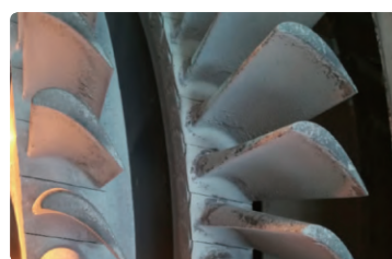
图9 2 # 催化烟机运行199天情况2 (2017年11月检修)
