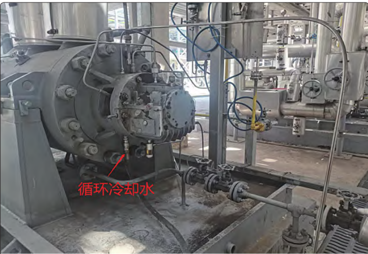
图3 泵密封冲洗管路改造
