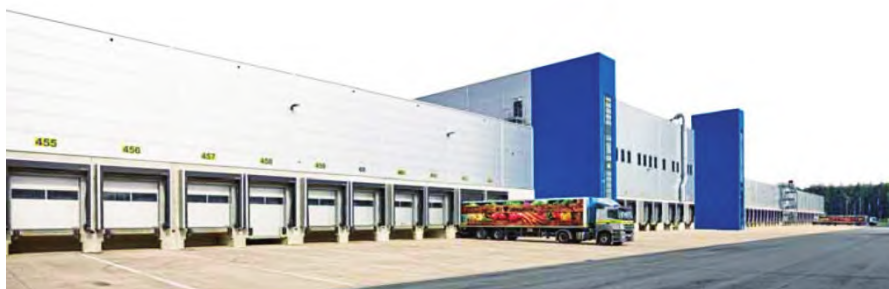
Edeka 公司在扩建 Wiefelstede 中央仓库时配用的主要是 Hörmann 公司研发生产的仓库门和装卸技术设备
