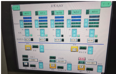
图3 PLC控制软件调试
