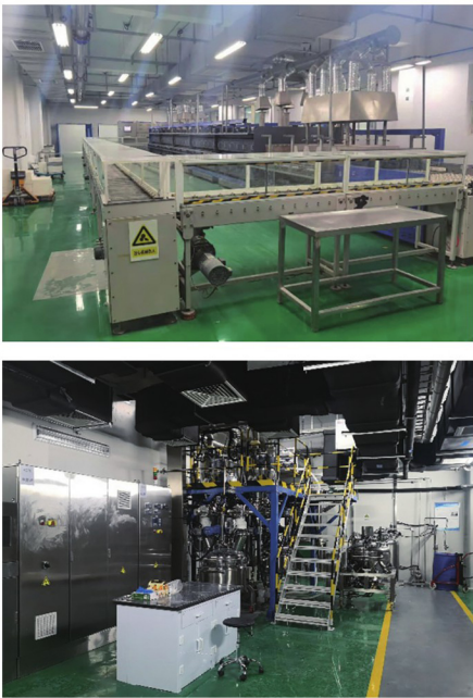
图9 浙江锋锂年产百吨级固体电解质材料中试生产线
