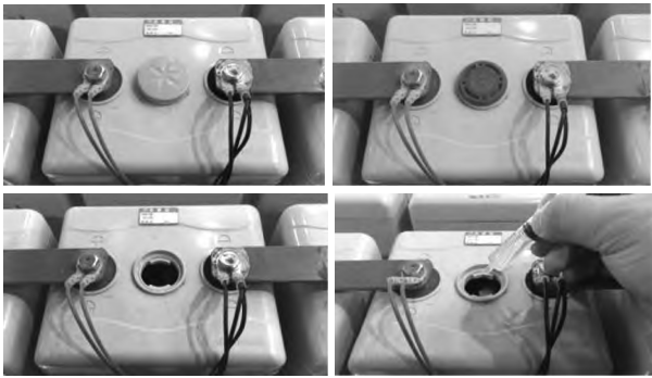
图3 生物大分子修复剂添加过程 Fig. 3 Adding process of biomacromolecule repair agent
