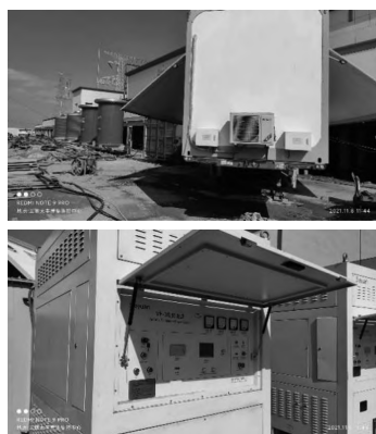
图9 海缆耐压试验现场
