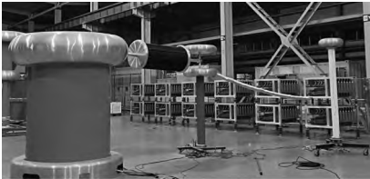
图 14 阀体试验 Fig. 14 Thyristor valve test
