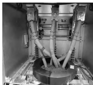
图10 电动机绝缘在线监测装置一次接线
