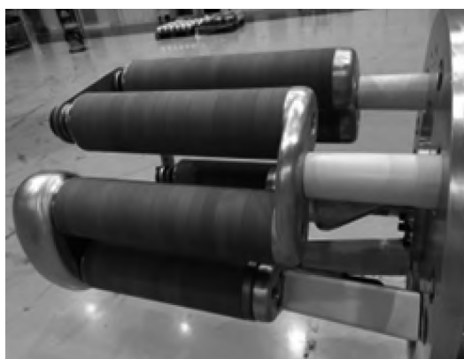
图4 断路器合闸电阻示意图
