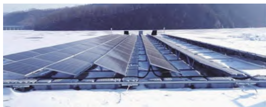
图1 光伏子阵列排列现场
