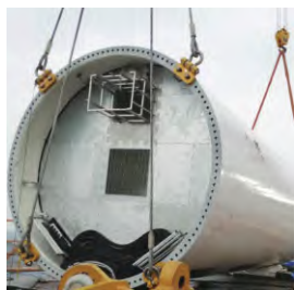
图12 塔筒上部法兰吊具安装
