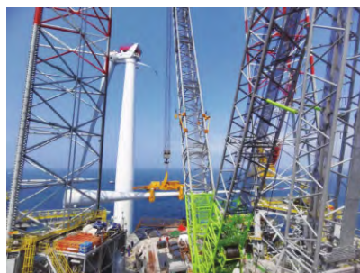
图8 单叶片吊装
