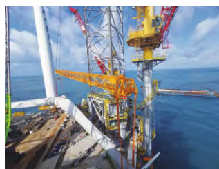
图21 第二支叶片与轮毂组装完成
