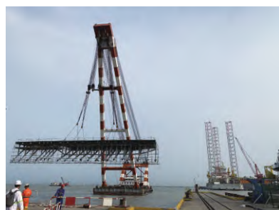
图7 浮吊吊装尾飘平台
