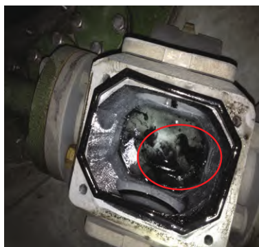
图3 瓦斯继电器内部聚集大量游离碳
