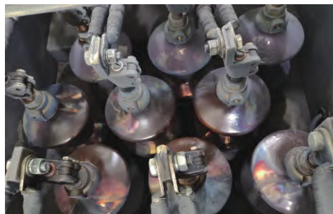
图2 瓷套管损伤情况
