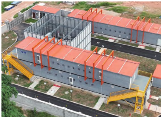
图4 乐山110 kV全模块化预制舱式变电站鸟瞰图
