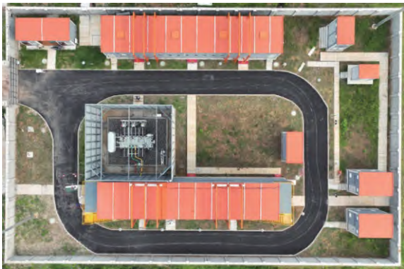
图3 乐山110 kV全模块化预制舱式变电站俯视图
