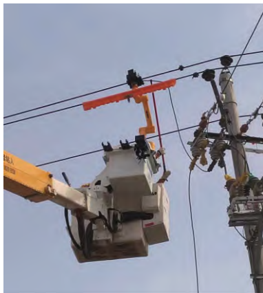
图4 RJ1100型机器人现场作业图
