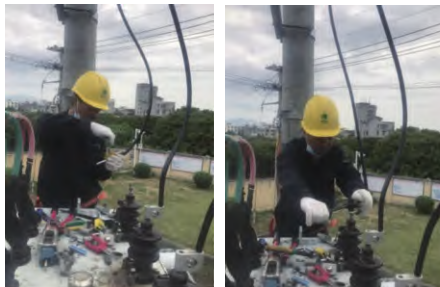
图9 新型快速接线端子现场安装应用场景
