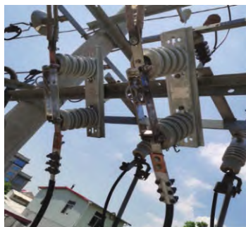
图1 现场应用中的铜铝过渡设备线夹
