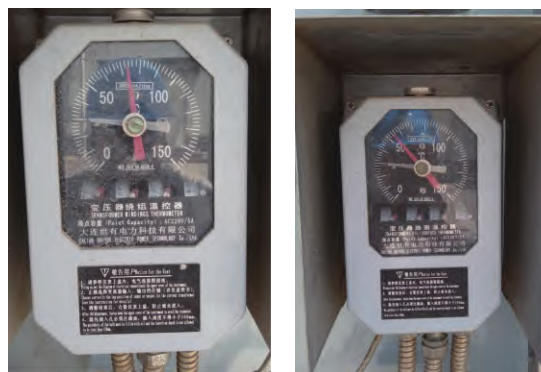
(a) 绕组温度计 (b) 油面温度计
