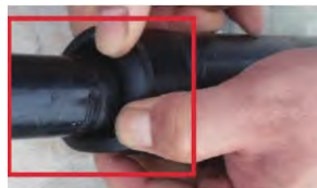
图7 电缆中间头错误包半导体带
