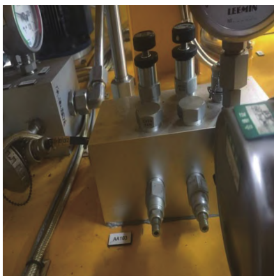
图2 双溢流阀块组件现场安装图
