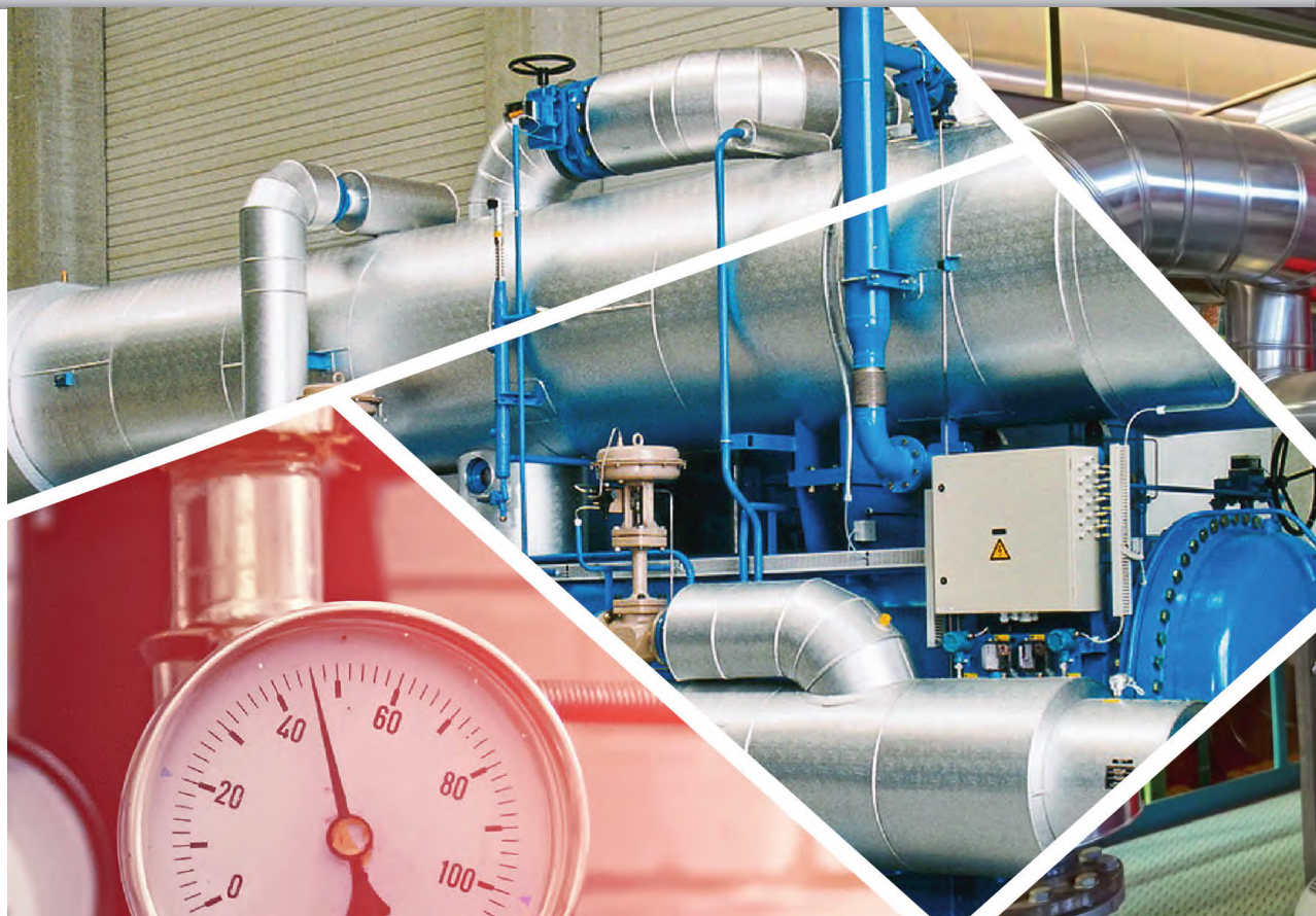
用于能源回收的热泵目前，高温热泵应用温度范围可以轻松达到 160℃ 左右
