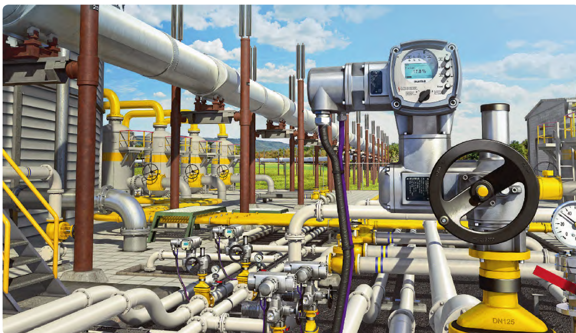
一个分散式执行器控制系统，例如 Auma 公司的 Sima 2 主站，既便捷了人们对重要数据的访问，同时也减轻了控制系统的负担
