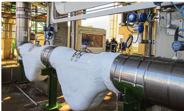
图3 KROHNE OPTIMASS 6400——应用在低温LNG上的科里奥利流量计
