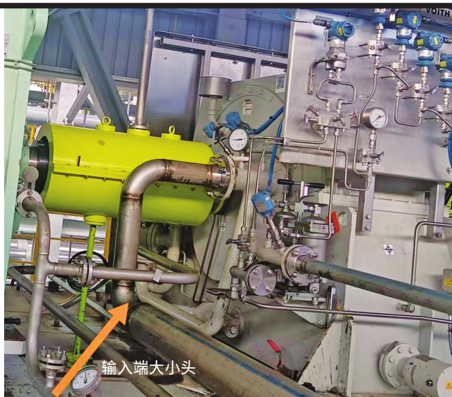
耦合器工作油入口处偏心变径 DN150 × 100
