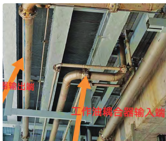
图 3 工作油冷却器润滑油管线 DN150
