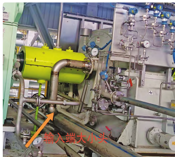
图 4 耦合器工作油入口处偏心变径 DN150 × 100
