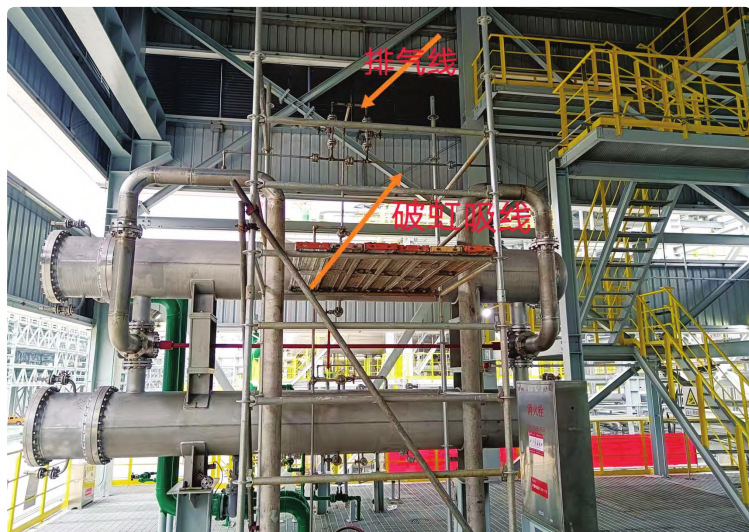
图 2 冷却器管线改造后
